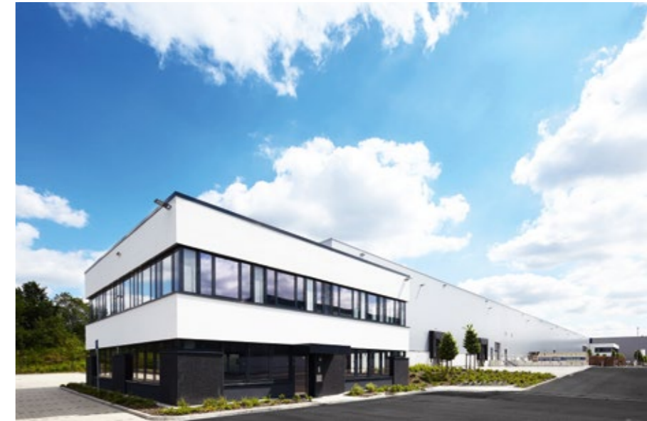
Kurze Wege: Der Glinkkamp hat den Mitarbeitern der ansässigen Unternehmen einiges zu bieten
