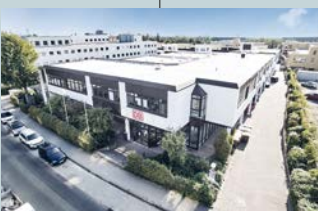
FRANKFURT II August-Schanz-Straße 23 Frankfurt am Main
