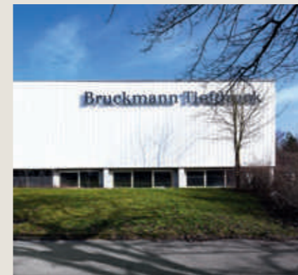
Druckwerk Mittenheimer Straße 64, Oberschleißheim
