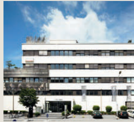
Cube Pallaswiesenstraße 201, Pfnorstraße 10-14, Darmstadt
