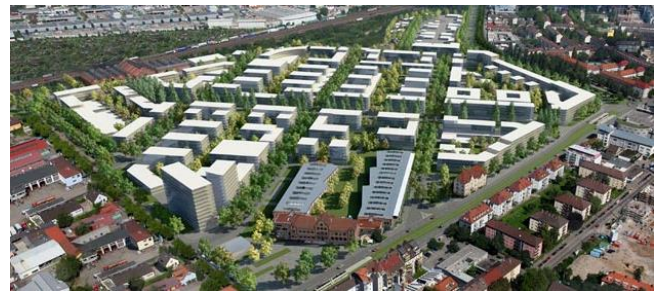
Abb. 05: Luftbild des zukünftigen Green Industry Parks auf dem Gelände des Güterbahnhofs (Quelle: Proprojekt)
